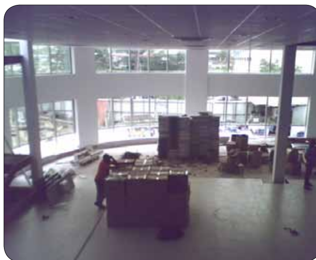
Obras da futura sede da SEFAZ
